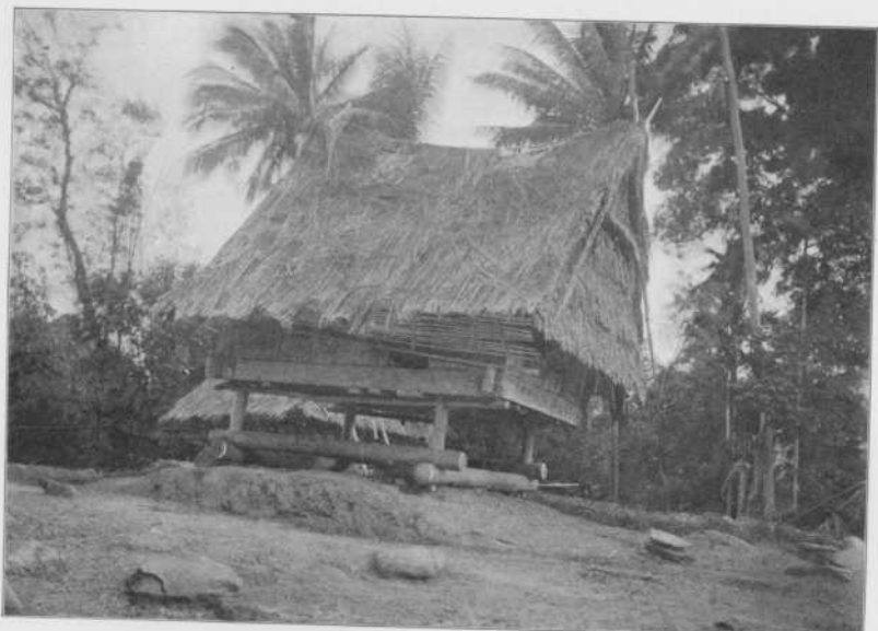
270. Uitwerking eener aardbeving op een huis in het landschap Koelawi. Effet d'un tremblement de terre sur une maison de la région de Koelawi. Foto J. R. F. Verschoor van Nisse.
