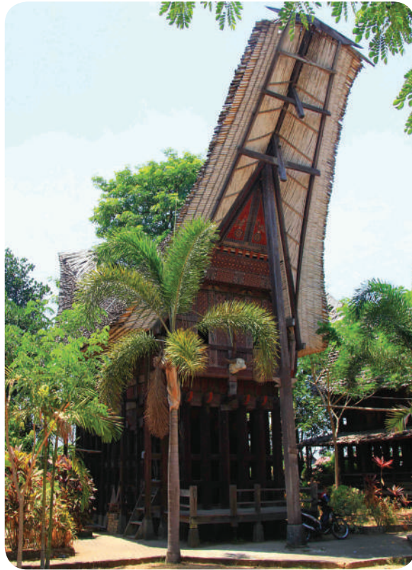
➤ Gambar 2.11. Tongkonan Pekamberan yang dihuni para bangsawan.
