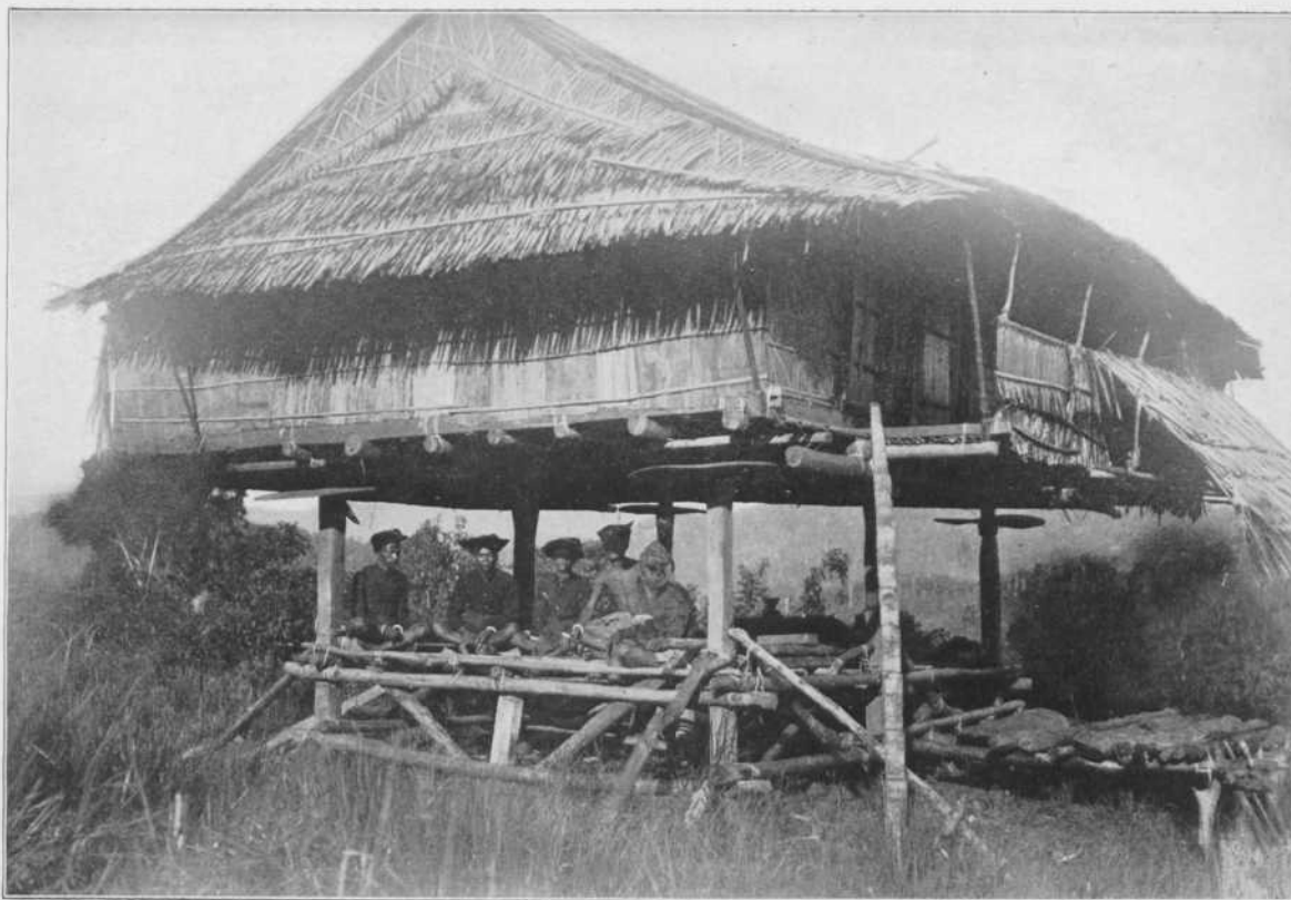
No. 41. HFDST. 18. „HUIZEN EN DORPEN”. EENE RIJSTSCHUUR (ALA), MET EENE VLOER ER ONDER, TOT VERBLIJF VAN VREEMDELINGEN OF TOT HET HOUDEN VAN BESPREKINGEN.
